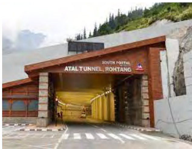
Atal Tunnel, Rohtang
