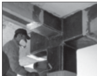
Fig. 5 Carbon Fibre Wrapping
