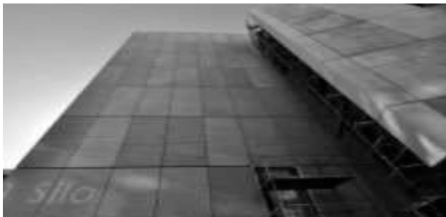
Fig. 8 : Precast Cladding Panels
