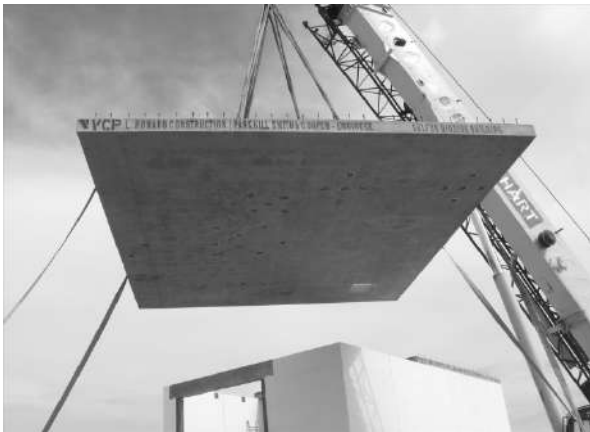
Fig. 6: Precast Slab
